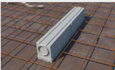
Bei Bedarf können mehrere Zentral-Übergangskästen aneinander gereiht werden.
