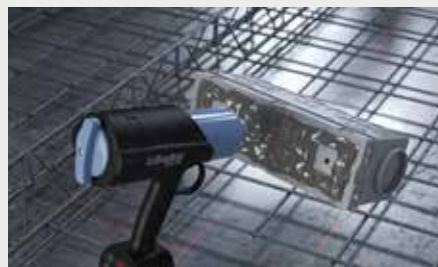
Befestigung mittels Heißkleber.
