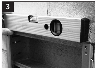
Halteleisten horizontal ausrichten ...
