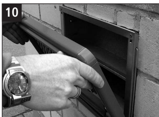
Haltestäbe aushängen, Front zuklappen.
