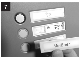
Beschriftete Namensschiebinlage einsetzen.
