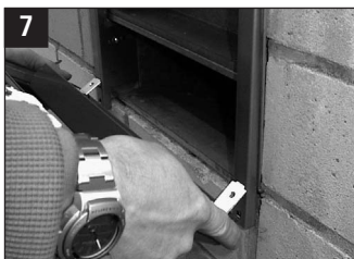
Scharniere der Front in der Halteleisten-Stanzung einhängen.
