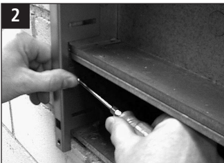
Halteleisten aufstecken und Blechschrauben ② leicht anziehen.
