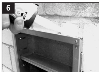
Obere Abdeckleiste mit Silikon abdichten.
