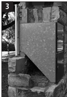
1 Kasten einmauern.
