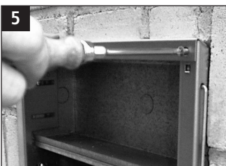
Obere Abdeckleiste einhängen und festschrauben ③
