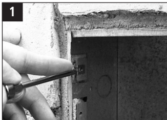
Federmuttern ① aufstecken.
