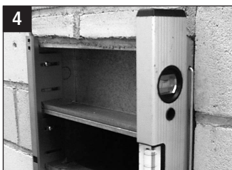
...Halteleisten vertikal ausrichten, Blechschrauben ② festdrehen.
