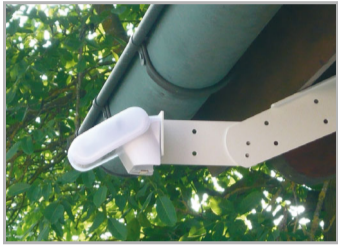
Abb. 8 Beispiel für den Einsatz eines Auslegers: Durch den Gelenk-Ausleger ragt der Sensor unter dem Dachvorsprung hervor.
