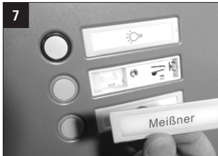
7 Beschriftete Namensschiele einlage einsetzen.
