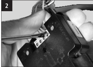
2 Sprechanlage anschließen.
