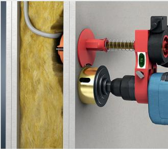
Einbauöffnung Ø 68 mm erstellen; im Bestand Mittenabstand 71mm mit Hilfe des Profix.
