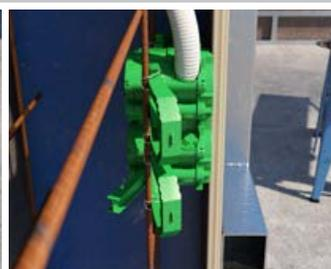
Durch einfaches Umdrehen der Dose ist auch eine Betonüberdeckung von **40 bis 60 mm** möglich. Hierzu sind die Rohreinführungen am Frontteil anzuordnen.
