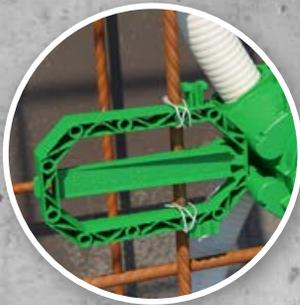
Befestigung mittels Rödel-
