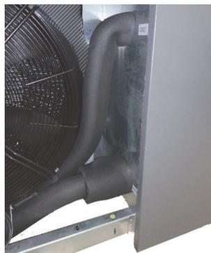
Zusätzlich muss noch die vorgefertigte und mit gelieferte Isolierung über den Filterkugelhahn geschoben werden.
