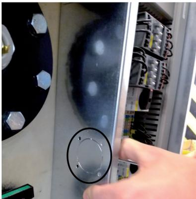
Anschließend den Schukostecker mit der Verkabelung montieren und die Kabel im Kabelkanal verlegen. Angeschlossen werden die Kabel laut Schaltplan E1082-XX.
