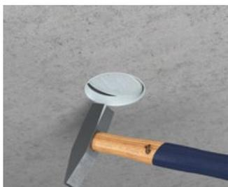
Nach dem Ausschalen der Betondecke bzw. -wand wird das Frontteil (z.B. Art.-Nr. 1281-01) mittels Hammerschlag geöffnet.
