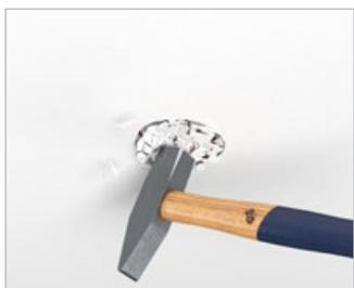
Nach dem Aushärten des Putzes lassen sich die Signaldeckel einfach mit einem zentralen Hammerschlag in das Gehäuse befördern ...
