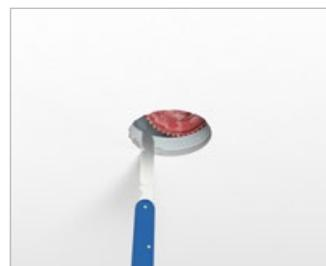
... und anschließend die in die Einbauöffnung ragenden Putzreste mit einem Messer entlang der inneren Aussparungskante entfernen, sodass eine saubere Installationsöffnung entsteht.
